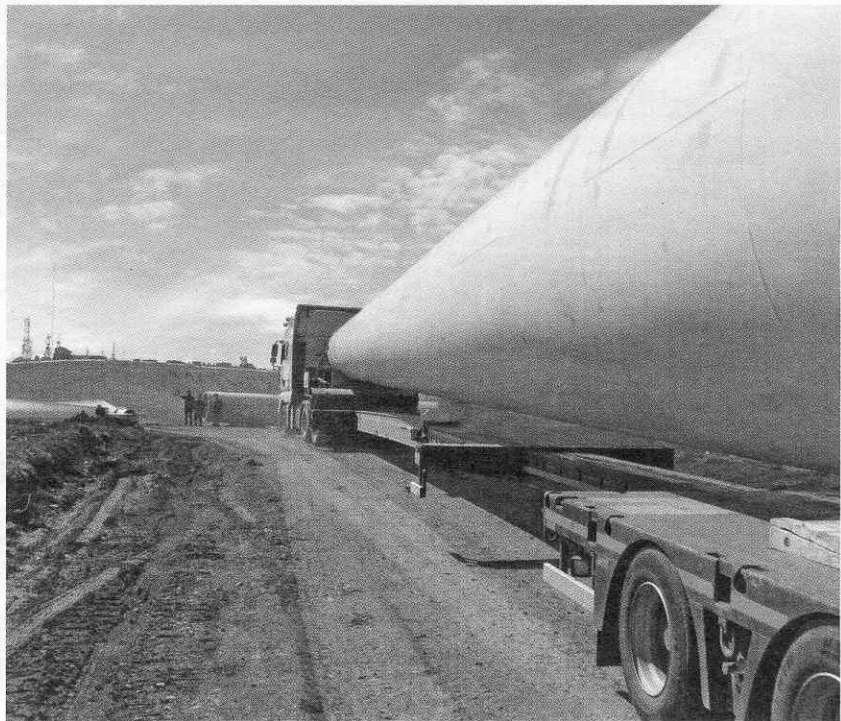
Die letzten Kilometer eines Windturms auf dem Weg von Bremen zu einem Windpark in Prisitna, Kosovo.
