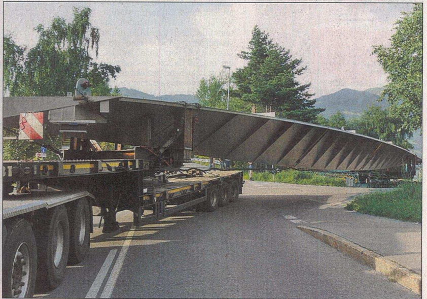
Brückentransport von der Firma Bitschnau in Nenzing nach Basel. Die Länge beträgt 50 Meter, das Gewicht 70 Tonnen.
